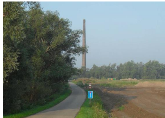
Schoorsteen vm. steenfabriek
