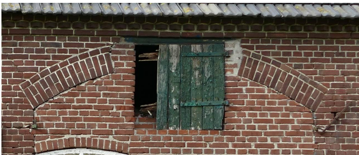
Figuur 12 – De segmentboog van de deeldeuren met links en rechts eronder nog een duim.
