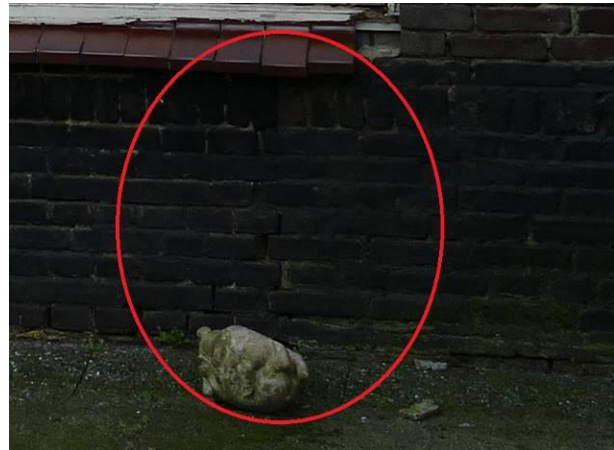
Figuur 25 – Sporen van een vroegere loopdeur in het woongedeelte van de achtergevel.
