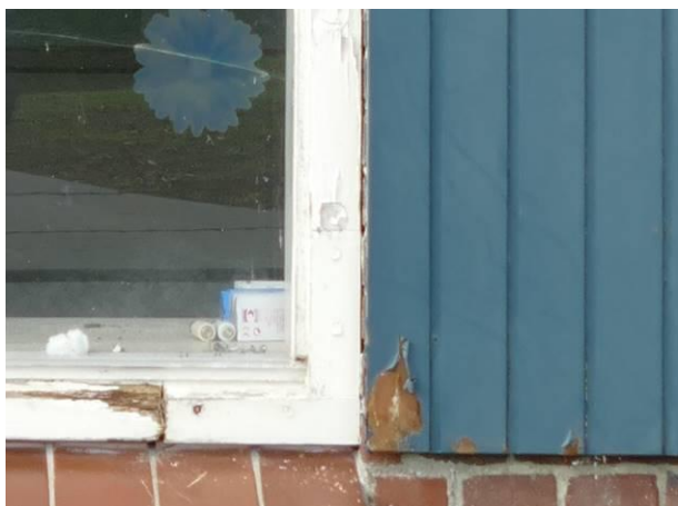
Figuur 8 – Deel van een woonhuisvenster waar de sporen van de voormalige duimen te zien zijn.
