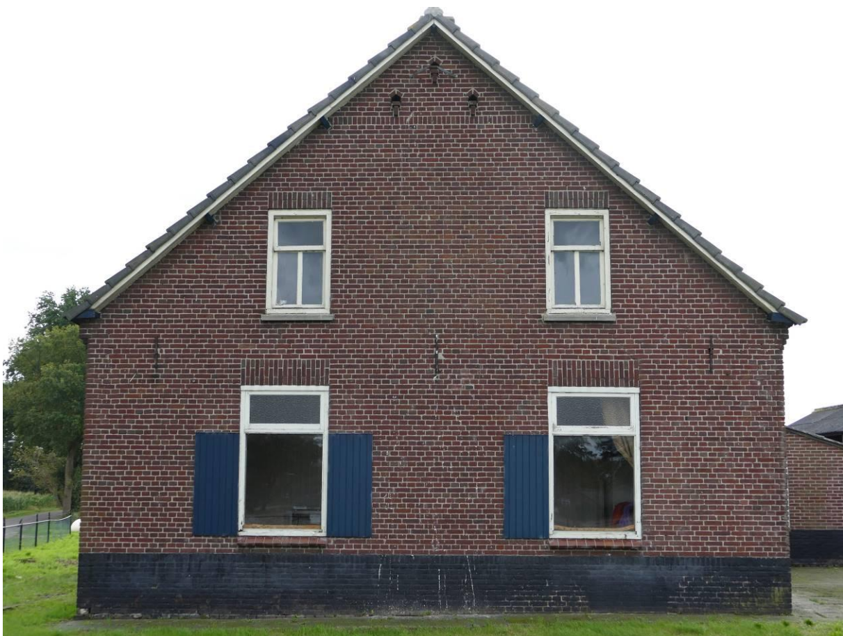
Figuur 26 – De kopgevel.
