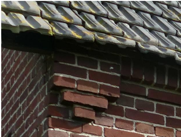
Figuur 24 – De hoekkolom en de rollaag in de achtergevel.
