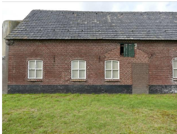
Figuur 4 – Deel van de voorgevel. Hier is de locatie van de voormalige schuurdeuren te zien.
