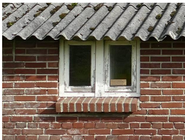
Figuur 22 – Het 2-ruits draairaam in het woongedeelte.
