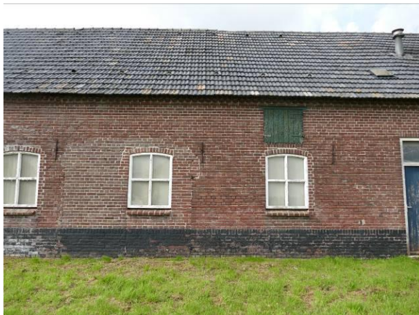
Figuur 3 – Deel van de voorgevel. De bouwsporen tonen aan waar de staldeuren hebben gezeten.
