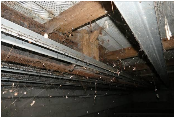
Figuur 37 – Een stalen ligger, met in het midden nog een korte staander.
