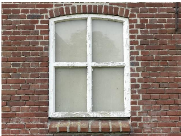
Figuur 10 – Een van de betonnen stalramen.
