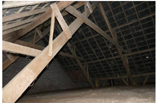
Figuur 38 – A-spanten.
