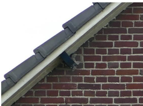
Figuur 28 – Een gording afgewerkt met een sierlijk ojief.
