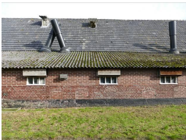
Figuur 19 – Detail van de achtergevel met de nieuwe stalramen en het verschil in steensoorten tussen het oude en opgehoogde deel.
