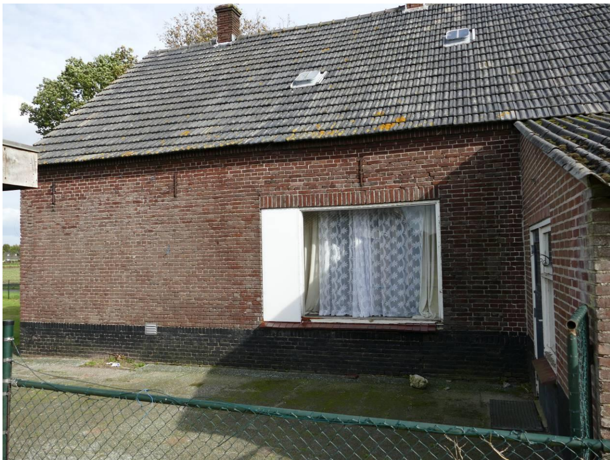
Figuur 23 – Het woongedeelte van de achtergevel.
