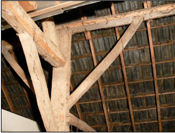
Foto 3, detail opname ankerbalkgebint
