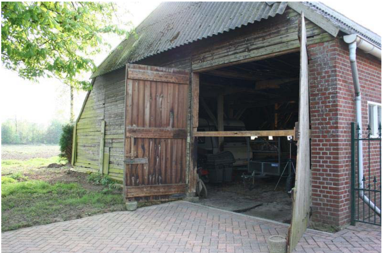
Voorgevel vanaf de rechterzijde
