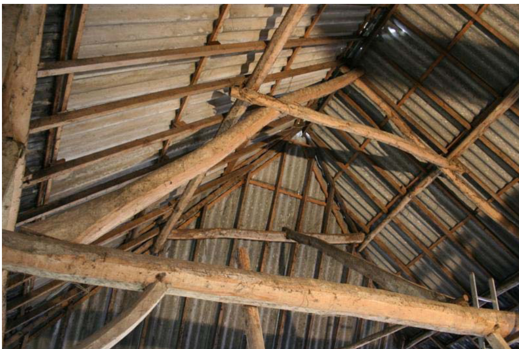
Kapsanten met vernieuwde sporen en golfplaten
