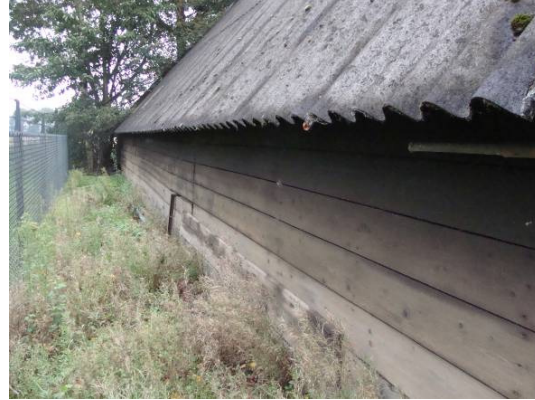
buitenwand van planken op regelwerk
