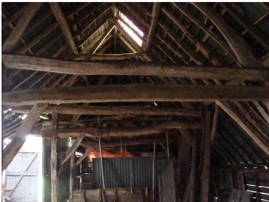
Spanten en gordingen op gebintconstructie
