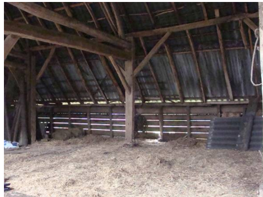
ankerbalkconstructie met dubbele balk
