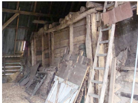
houten wand tussen schuur en stalgedeelte
