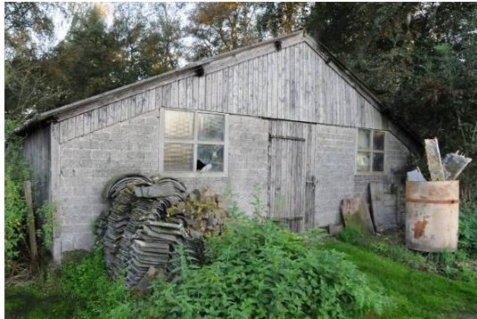
achterzijde van de bestaande schuur in Ledeacker
