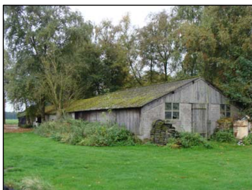
Foto 1. Te slopen schuur vanuit het noorden
