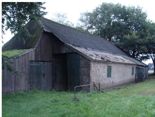
Schuur met inham tbv plaatsing deeldeuren
