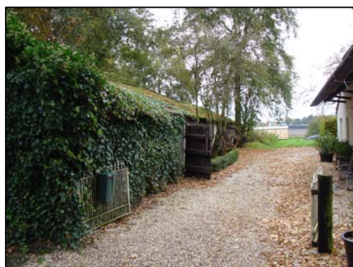
Foto 2. Te slopen schuur vanaf oprit
