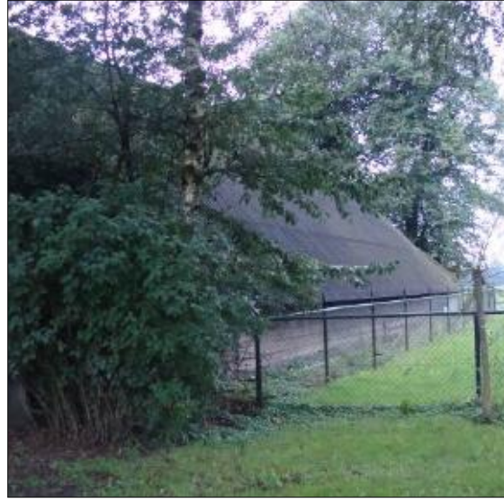
Langsdeelschuur aan Broekkant achterzijde
