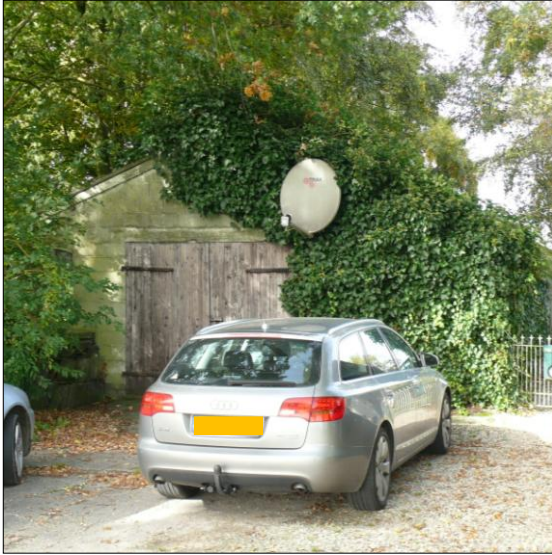
Bestaande schuur straatzijde
