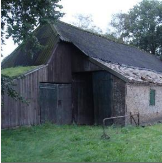
Langsdeelschuur aan Broekkant voorzijde
