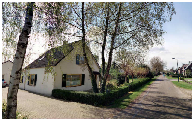
Streetview met vooraan links de bestaande woning Hank 31
