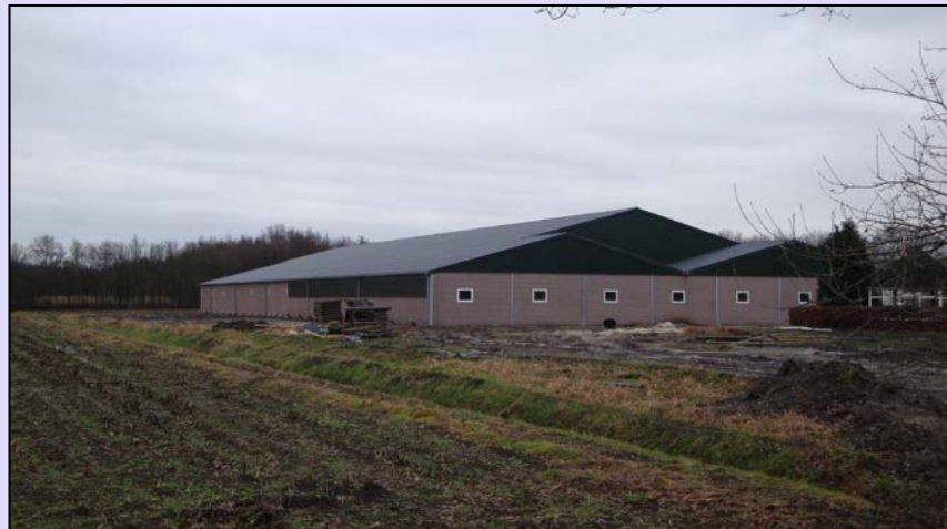
Figuur 2.2 Foto nieuwe zeugenstal D
