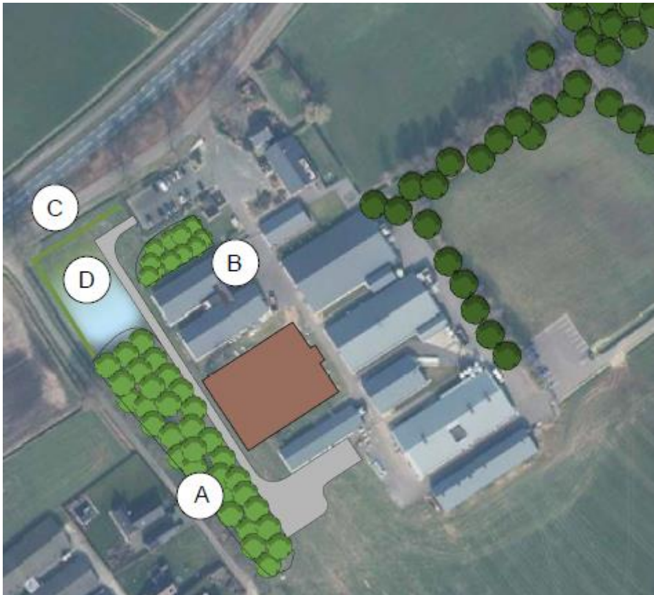
Figuur 2.3 – Luchtfoto bedrijf
