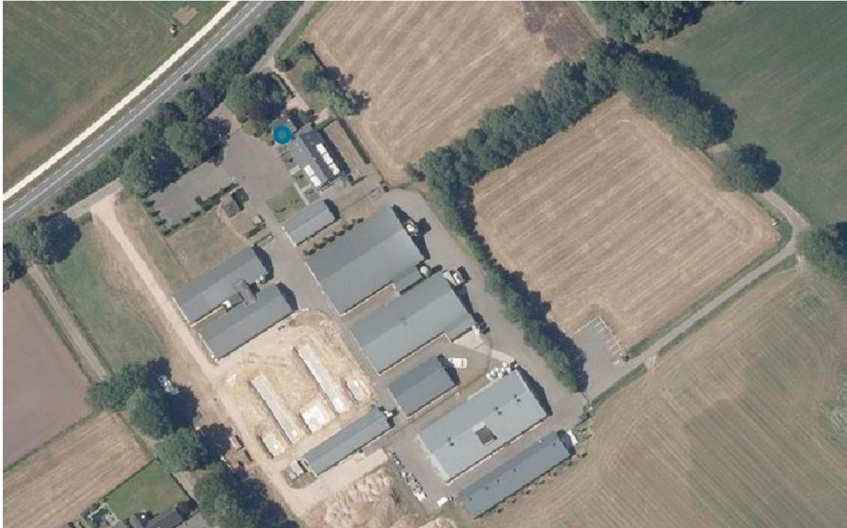
Figuur 2.2 – Luchtfoto bedrijf
