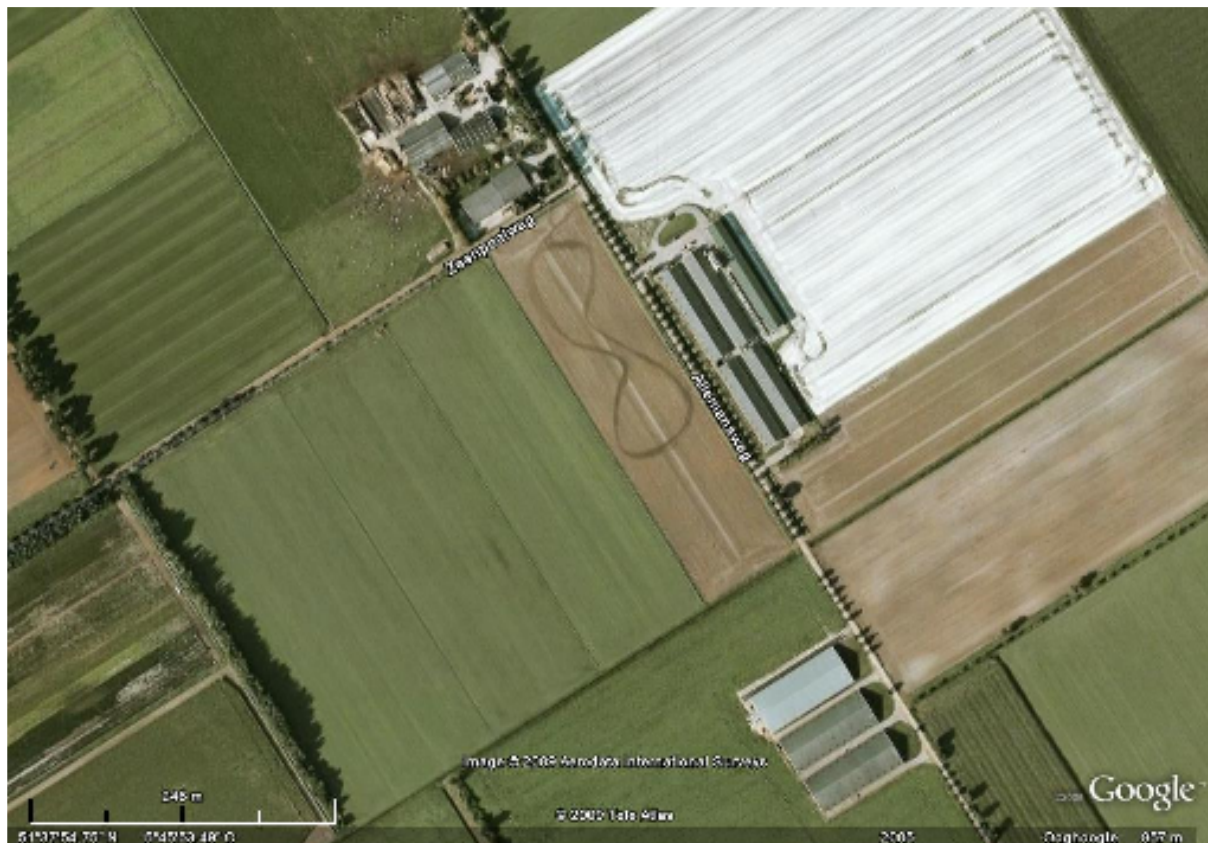
Afbeelding 11 Overzicht bouwblokken 1, 2 en 3
