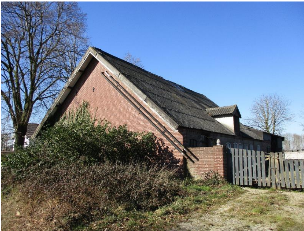
Figuur 1 De planlocatie is gelegen aan de Zandkant 1a te Sint-Anthonis en bestaat uit een schuur opgetrokken uit gemetselde steense muren en een zadeldak met golfplaten.
