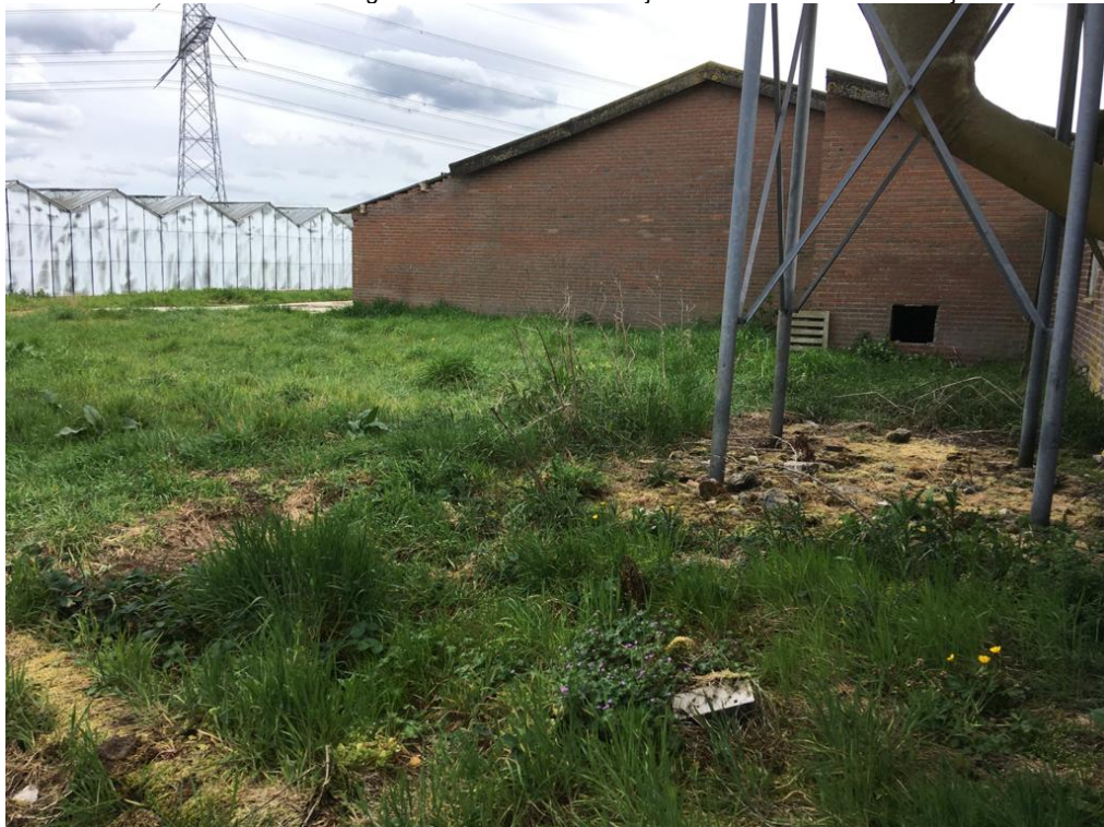
• Afbeelding 20: aanzicht vanuit achterzijde woonhuis met aan de voorzijde resten van stal
