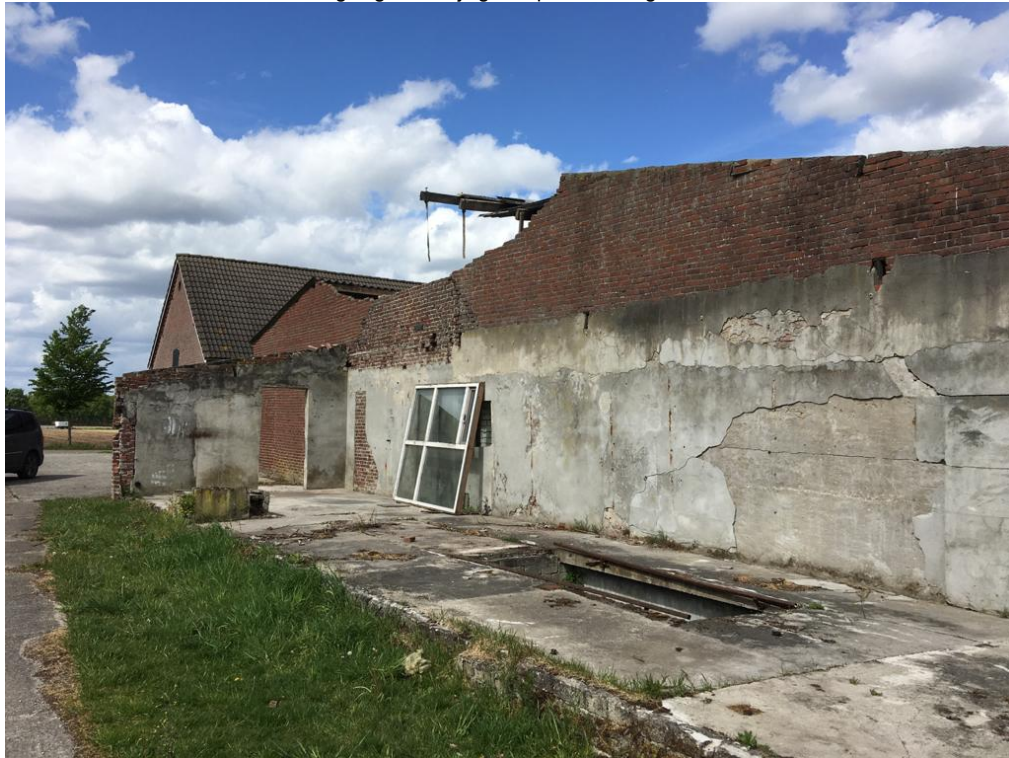
• Afbeelding 4: gedeeltelijk gesloopte voormalige varkensstal
