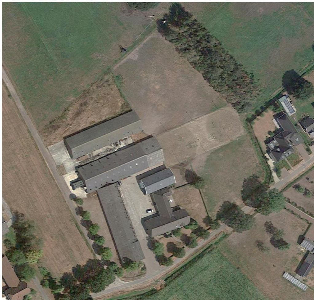
Figuur 2. Huidige situatie slooplocatie Bus 3 te Oploo
