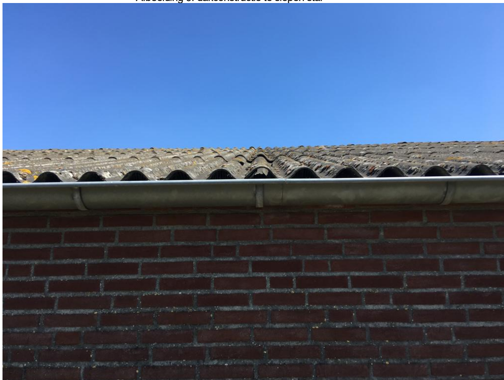
Afbeelding 9: dakconstructie te slopen stal
