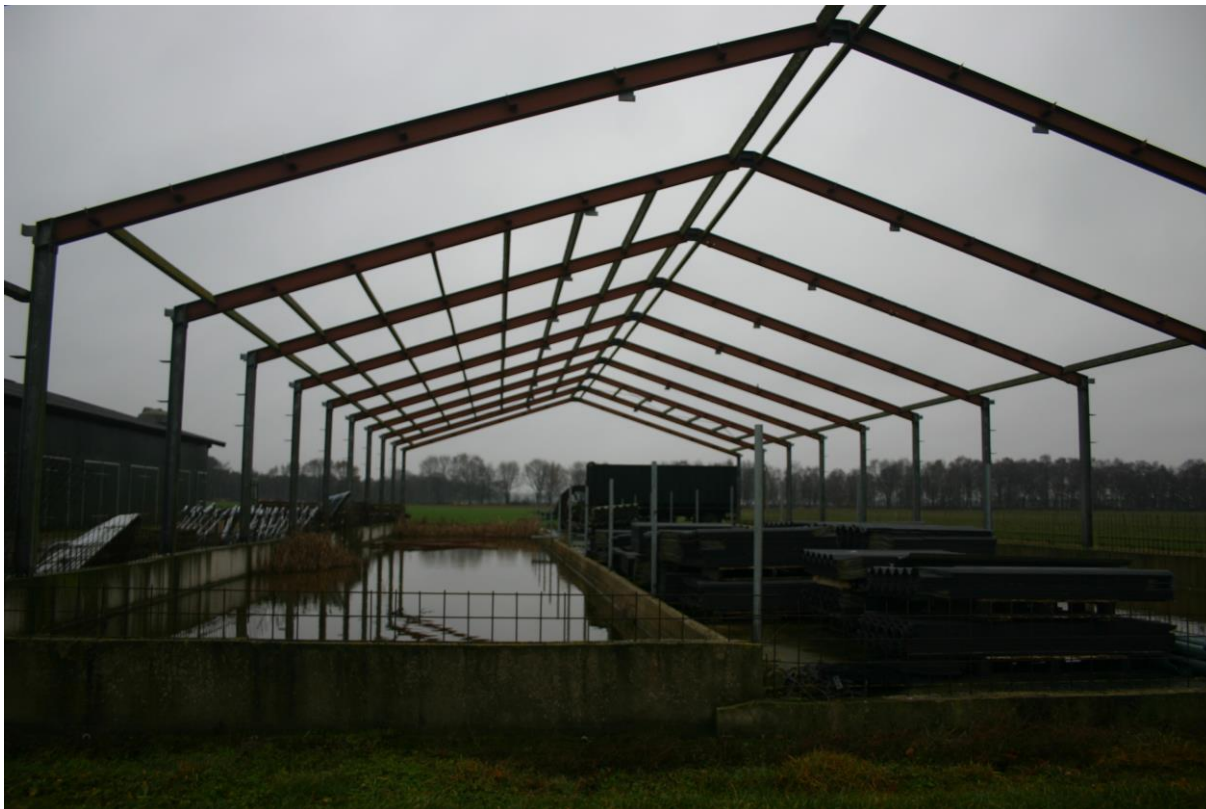
Figuur 2. De af te bouwen opfokgeitenstal (5 in figuur 1).
