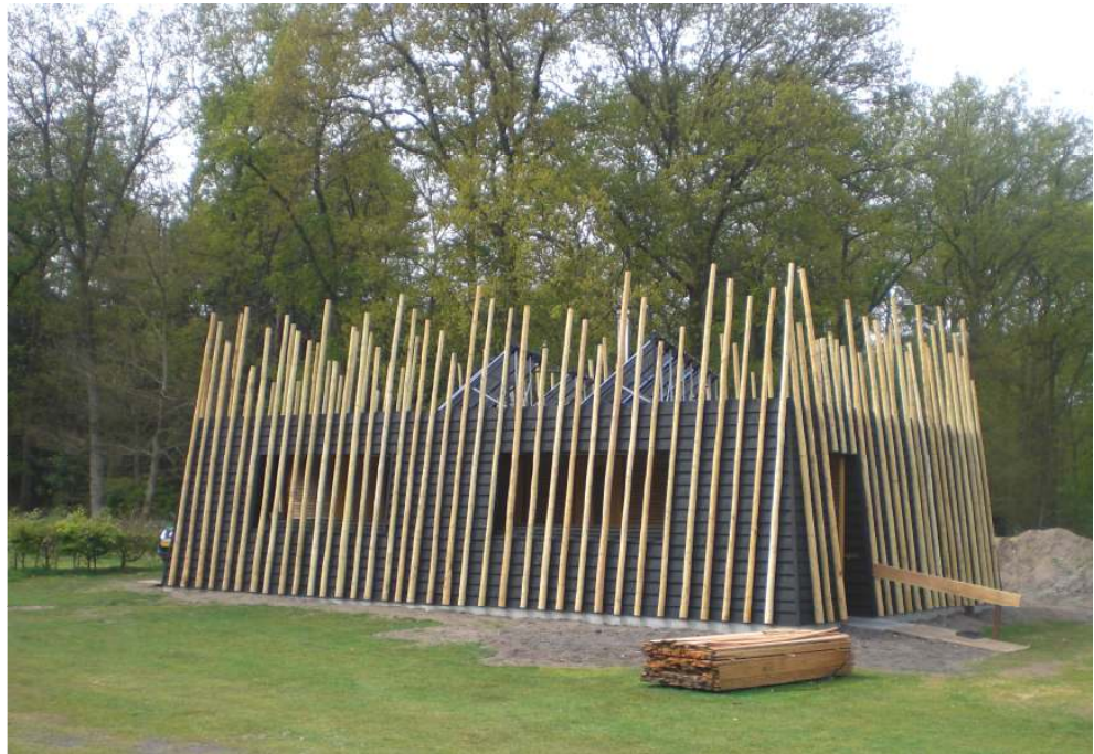
sanitair gebouw (in aanbouw)
