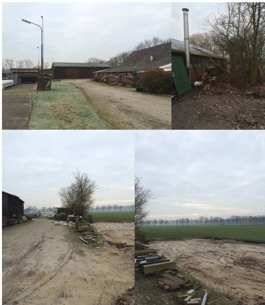
• Afbeelding 2 Foto's plangebied – bedrijfsgebouwen en (te slopen)priël
