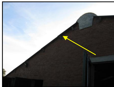
Figuur 16. Ruimte langs dakrand.
