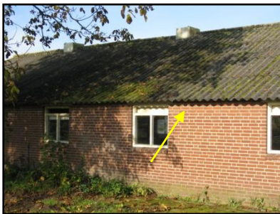
Figuur 15. Overhangende golfplaten geschikt voor vleermuizen.
