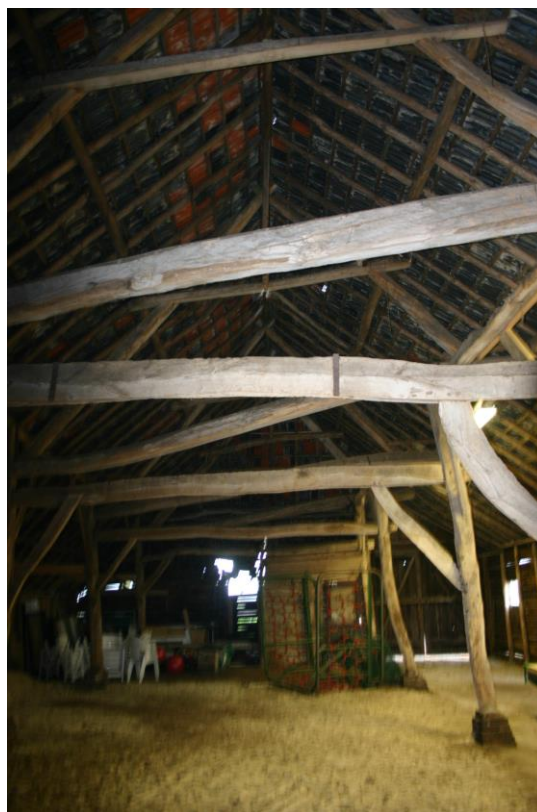
Figuur 5. De te slopen schuur van binnen gezien.
