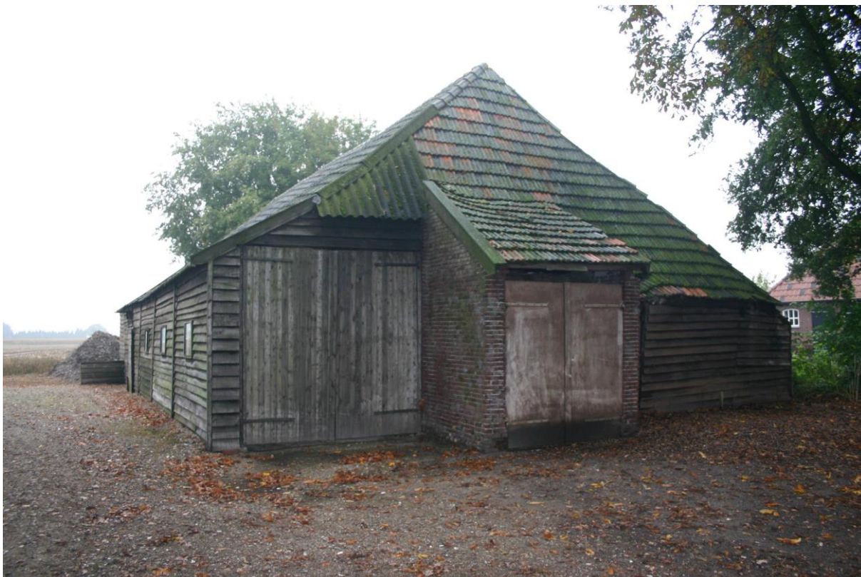
Figuur 2. De te slopen schuur, gezien vanuit het zuidoosten.
