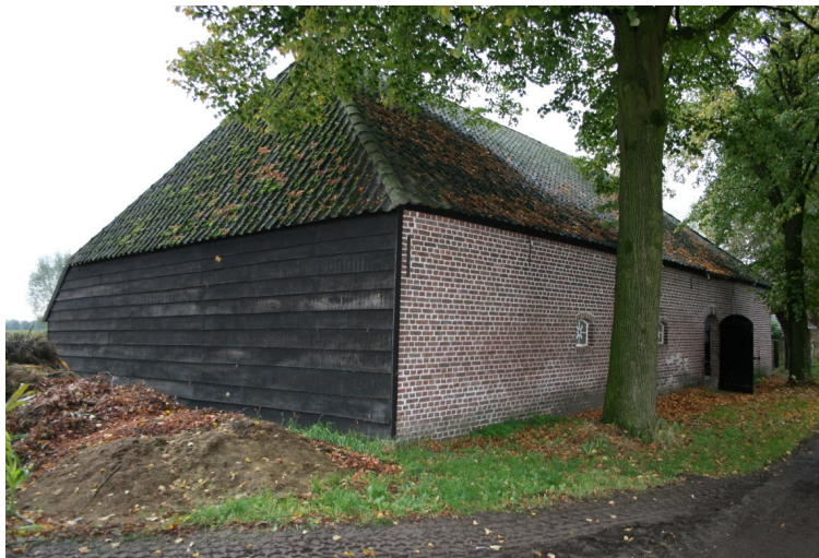
Voorgevel vanaf de linkerszijde
