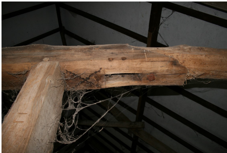
De andere zijde van de balk met kruisdecoratie, de sleuf waar de korbeel van oorsprong in stak (naar rechtsonder), de las met bout en links op de staander telmerk II
