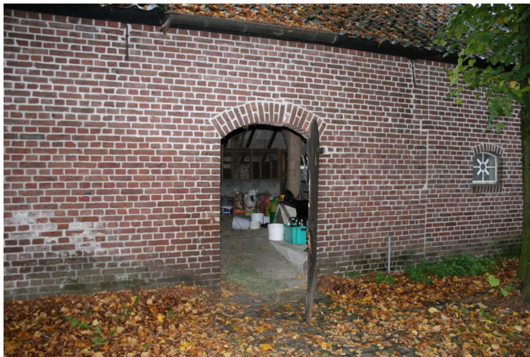
Loopdeur onder segmentboog, naad in het metselwerk en spinnenkopraam
