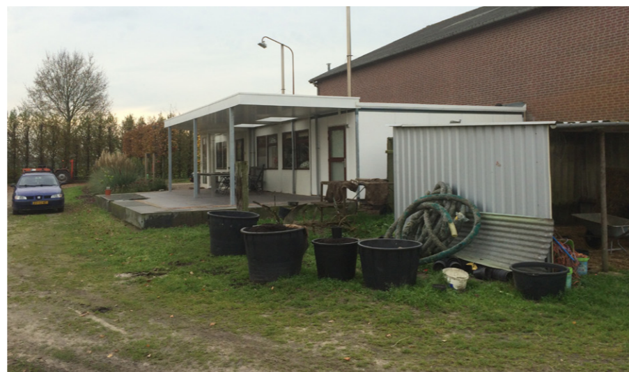
Aanbouw met kantoor en ontvangstruimte
