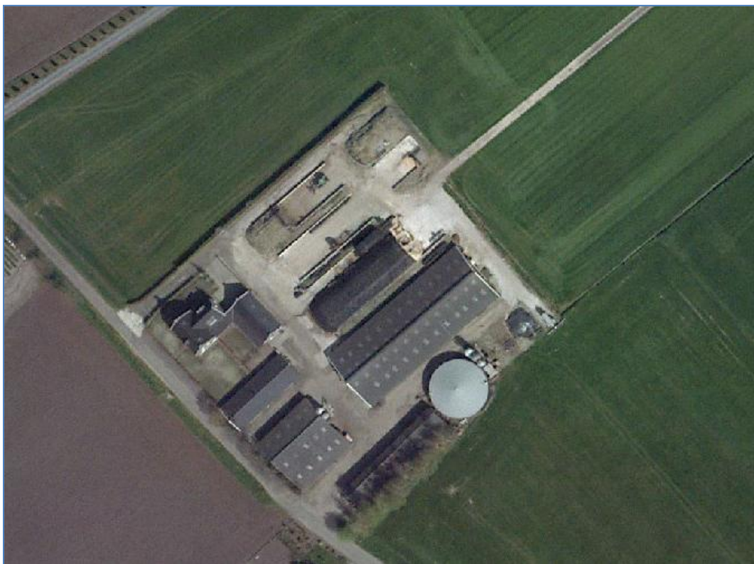
Figuur 7: luchtfoto bestaande situatie Hoogveld 2
