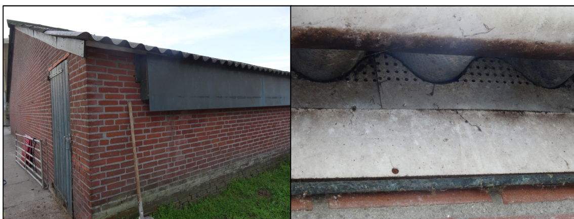
Figuur 6: De te slopen varkensstallen
