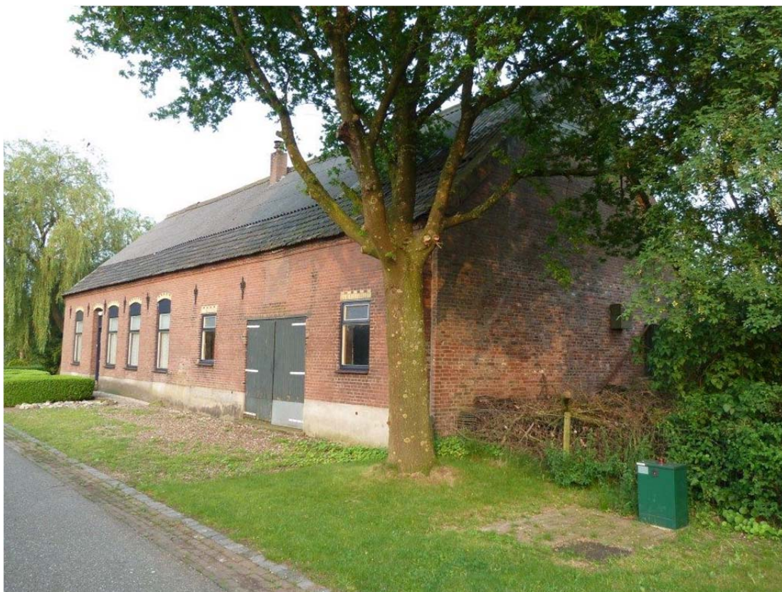
Aanzicht pand (straatzijde Steenakker) met bedrijfsgedeelte
