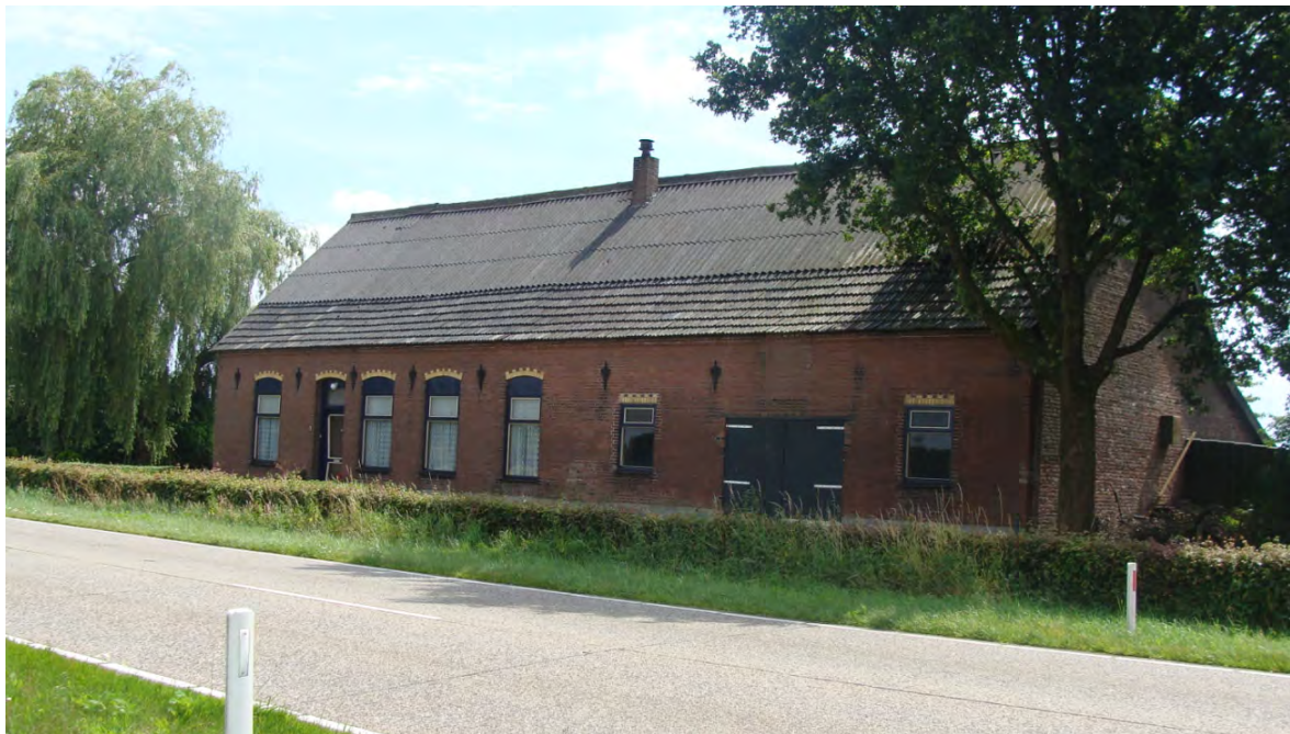
Huidige voorgevel gezien vanaf de overzijde van de straat
