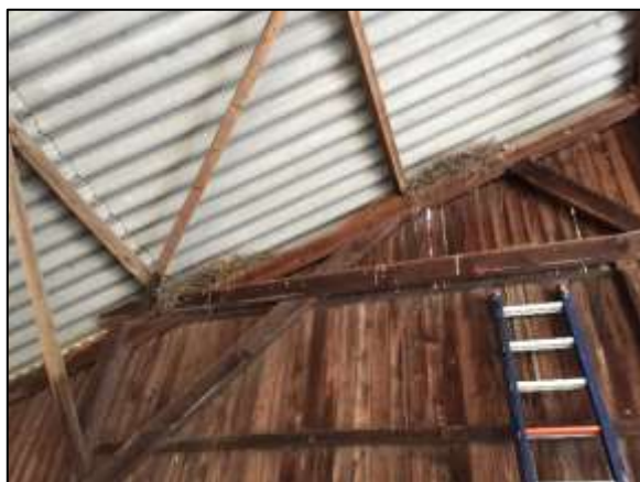
Foto 5. Houtduifnesten in kapschuur 2
