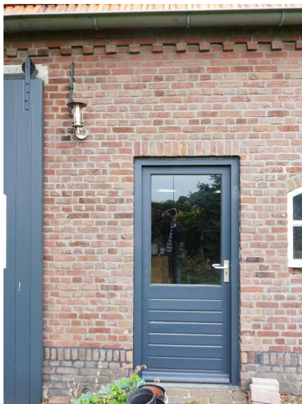
Figuur 19 – Het stalraam in het dichtgezette gedeelte in de gevel.
