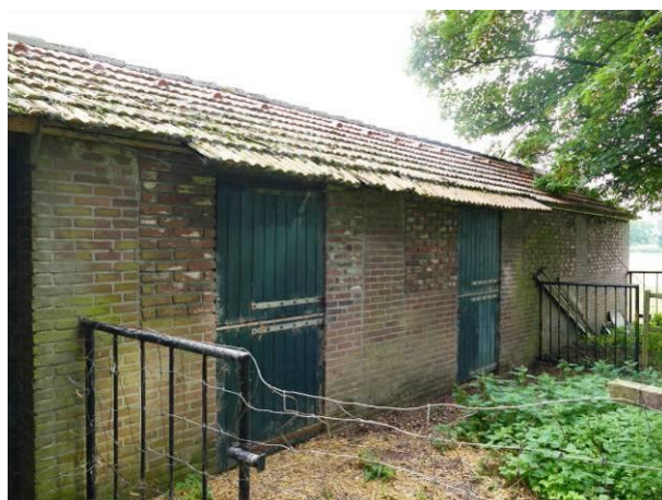
Figuur 56 – Het noordelijk deel van het lange bijgebouw. De huidige paardenstal.
