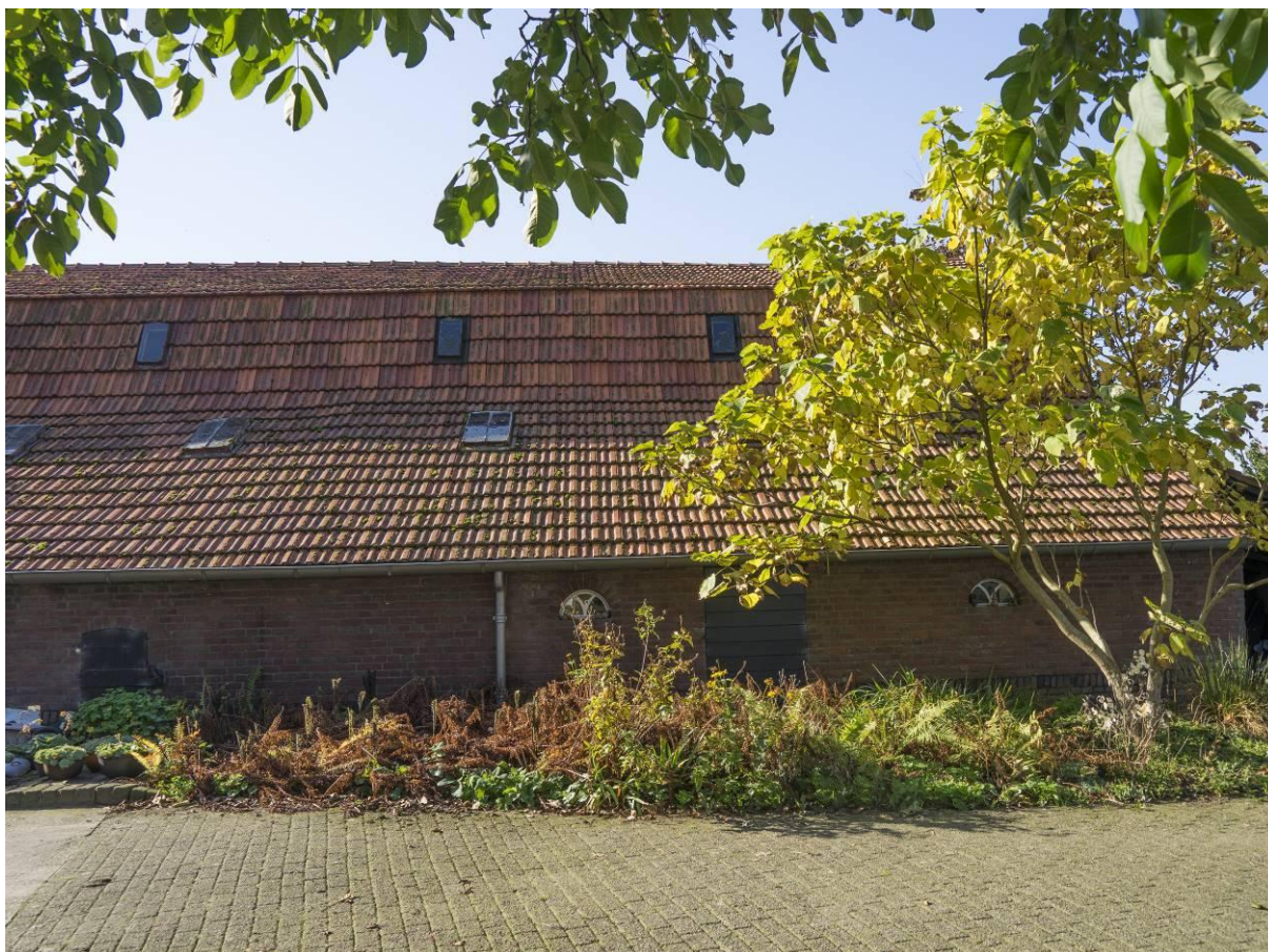
Figuur 29 – Bedrijfsgedeelte van de noordgevel.
