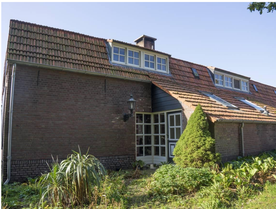
Figuur 34 – Het woongedeelte van de noordgevel.
