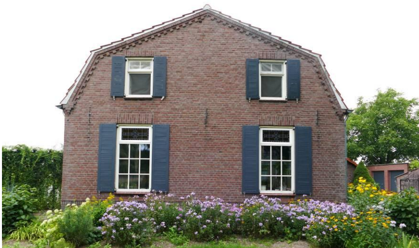
Figuur 35 – De kopgevel.
