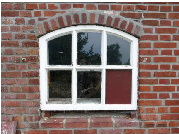
Figuur 19 – Het stalraam in het dichtgezette gedeelte in de gevel.
