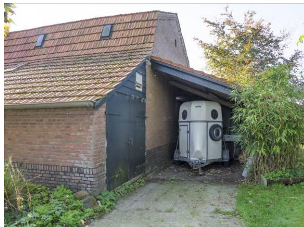
Figuur 24 – Zicht op de eindgevel vanuit het noorden.
