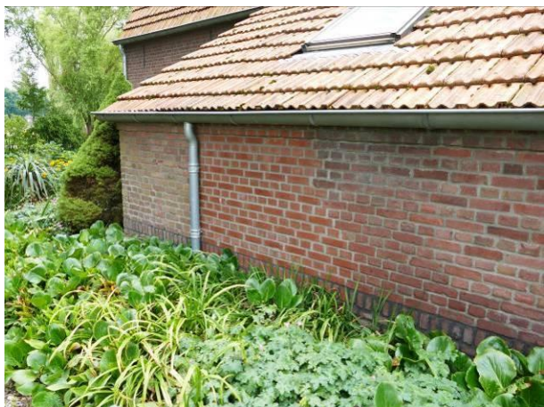
Figuur 32 – Een dichtgezet deel in de noordgevel.
