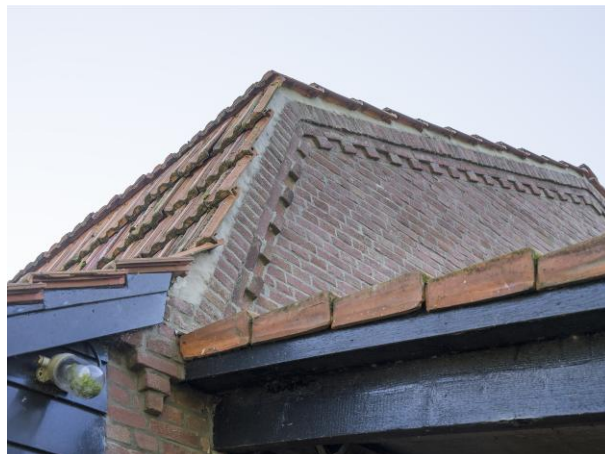
Figuur 27 – De geornamenteerde gevelbeëindiging. Linksonder is de console te zien.
