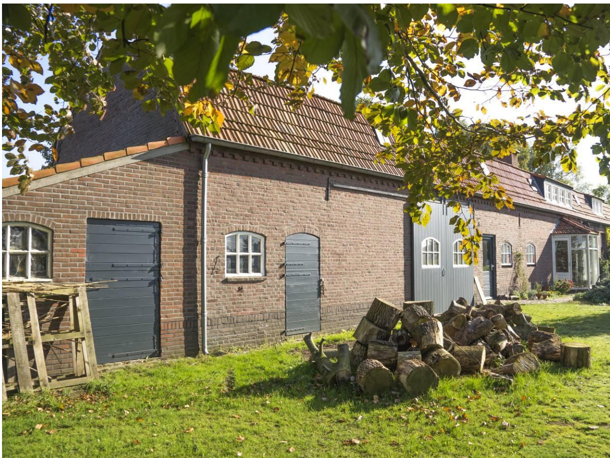
Figuur 12 – Zuidgevel vanuit het noordwesten.
