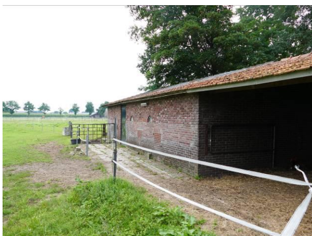
Figuur 59 – De paardenstal met in het midden de sporen van twee dichtgezette varkensdeurtjes.
