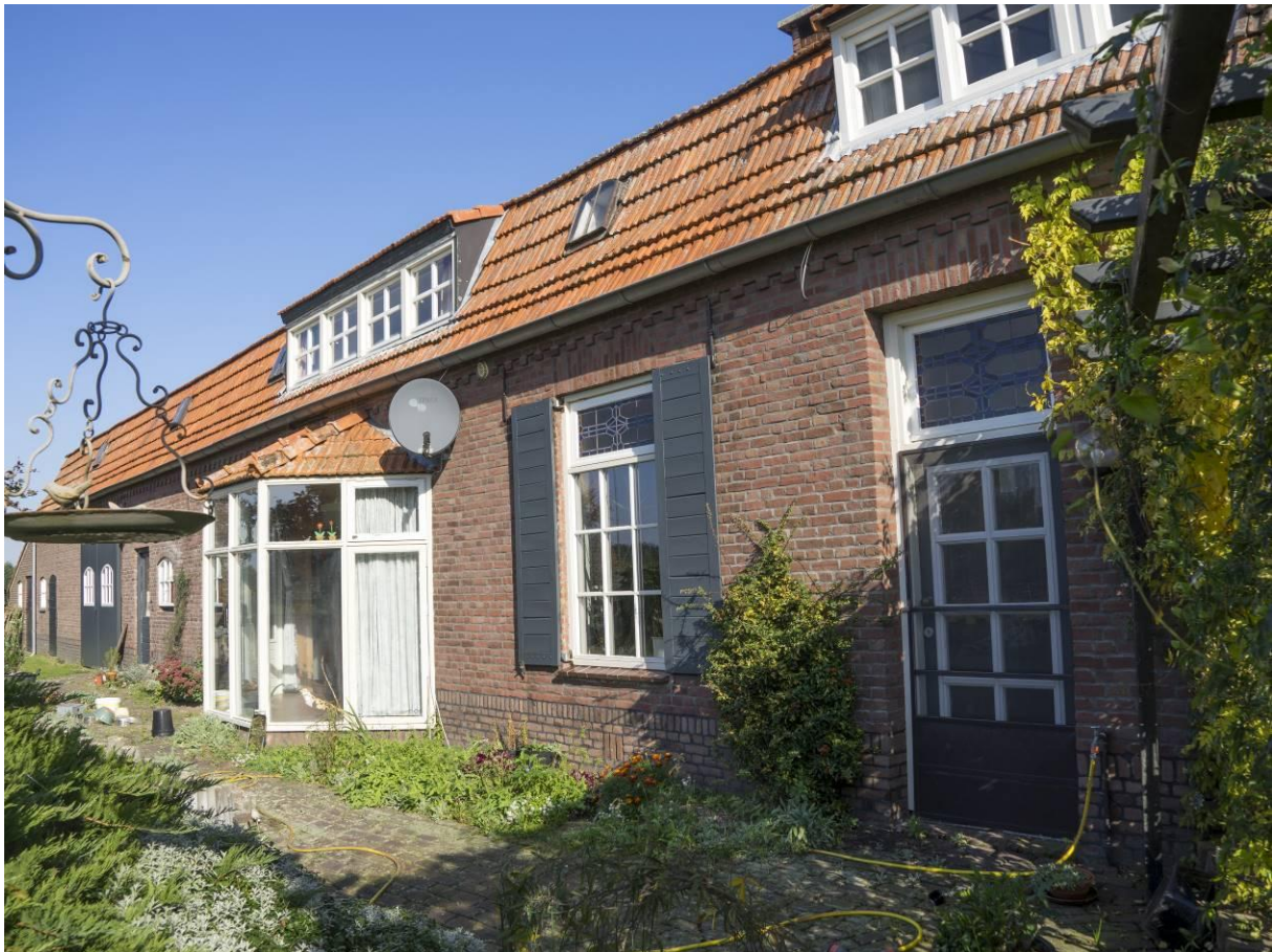
Figuur 13 – Zuidgevel vanuit het zuidoosten.
