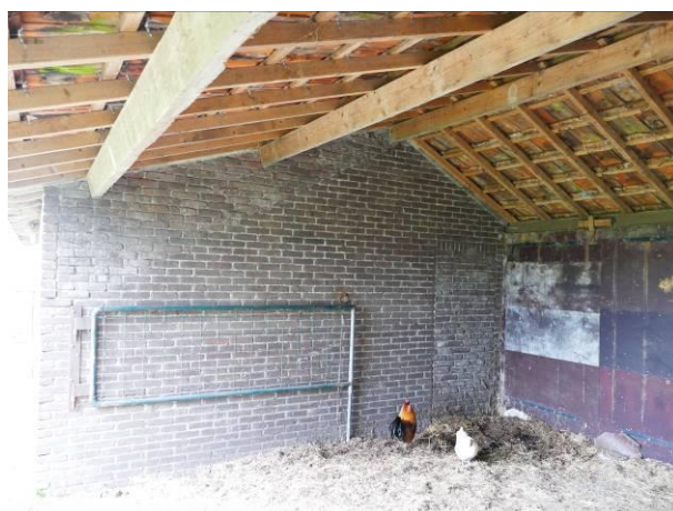
Figuur 60 – Zuidmuur van de paardenstal waarin de vorm van het lessenaarsdak te zien is.
