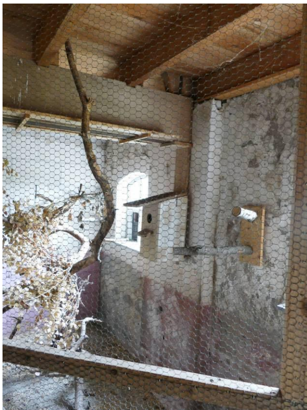
Figuur 48 – Een gemetselde penant ten behoeve van de stalen balk.
