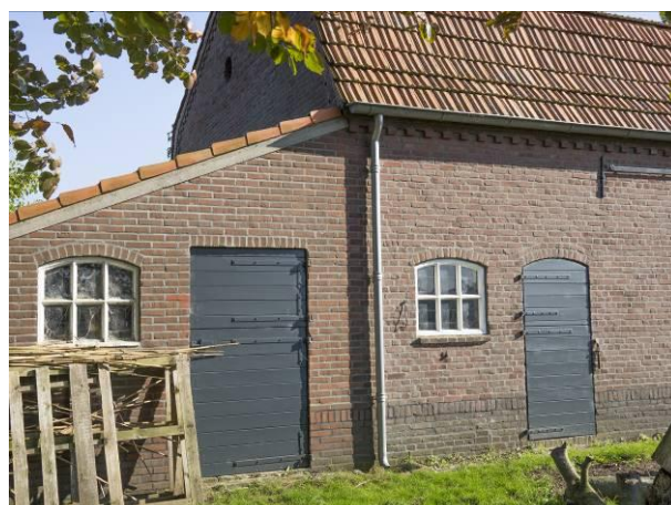
Figuur 22 – Het westelijk deel van de zuidgevel.
