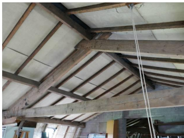
Figuur 54 – Een spant. Bovenin de nokbalk en links een gording.
