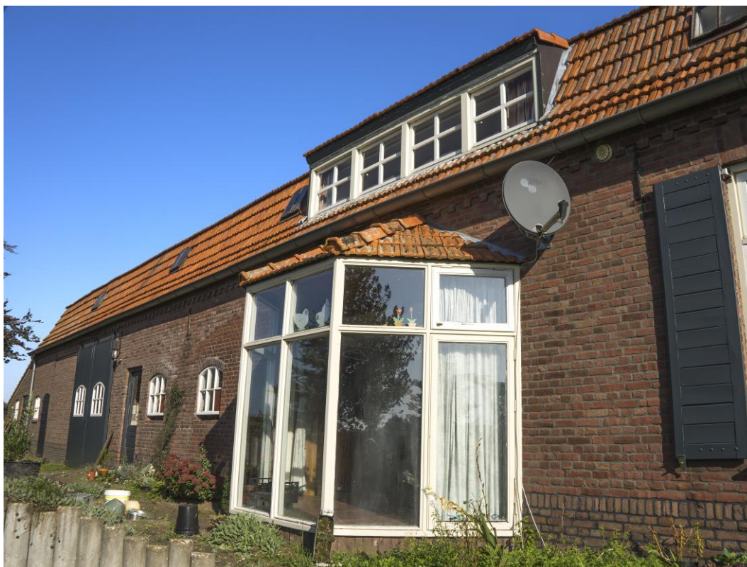
Figuur 18 – Links van de erker is het bouwspoor van de mestdeuren te zien.
