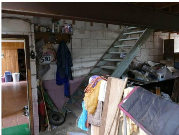
Figuur 46 – De muur en deur tussen huidige woon- en bedrijfsdeelte.
