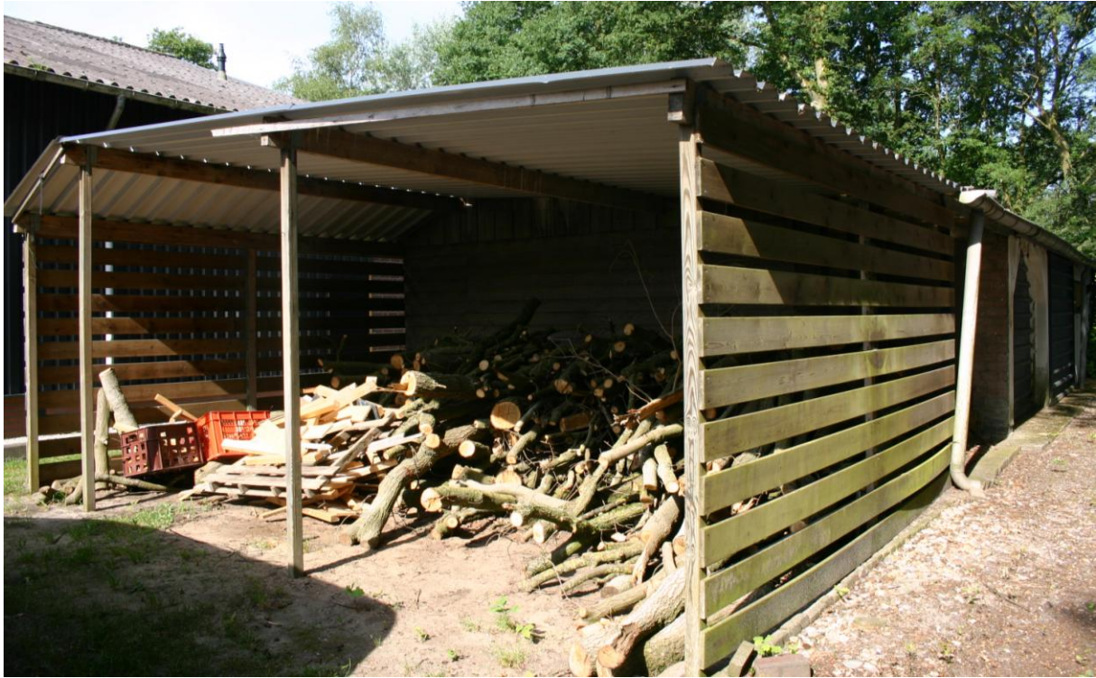
Figuur 5. Het opslaggebouw heeft enkelwandige muren en een enkelwandig, golfplaten dak. Hierin zijn twee houtstapels opgeslagen.
