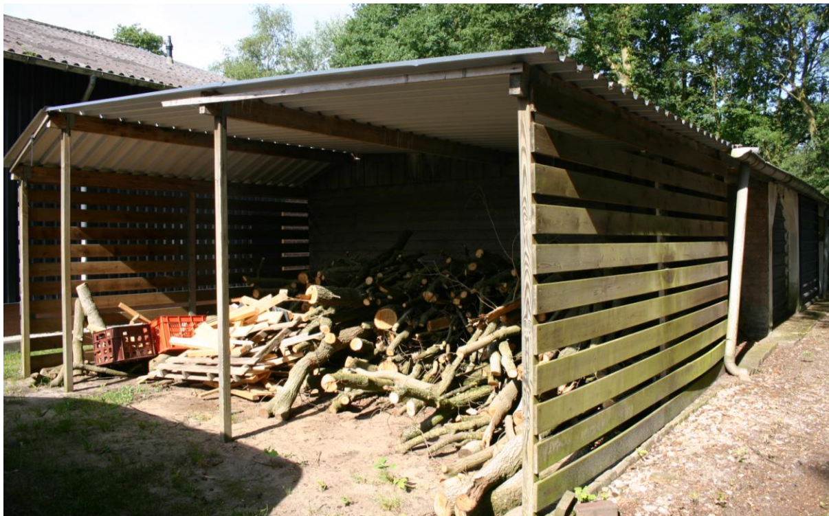
Figuur 5. Het opslaggebouw heeft enkelwandige muren en een enkelwandig, golfplaten dak. Hierin zijn twee houtstapels opgeslagen.
