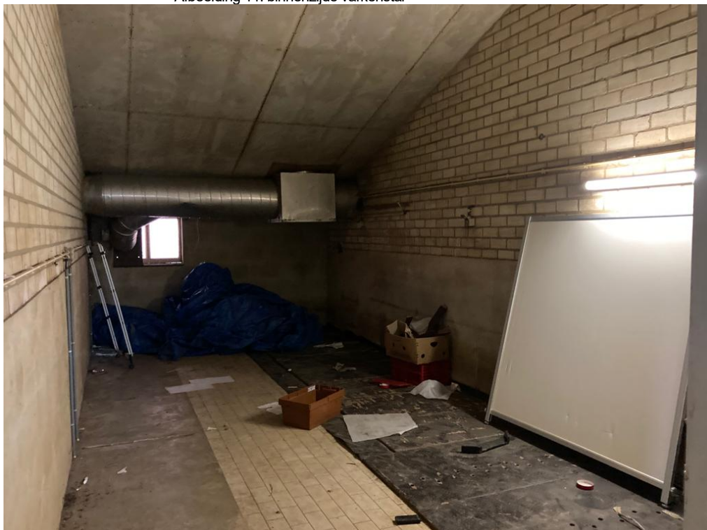
• Afbeelding 11: binnenzijde varkenstal
