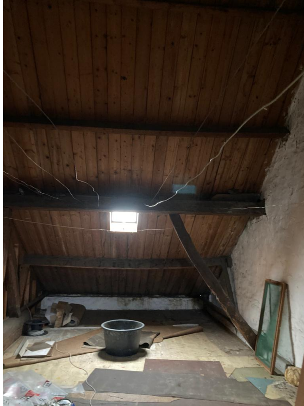
• Afbeelding 12: zolder woonhuis
