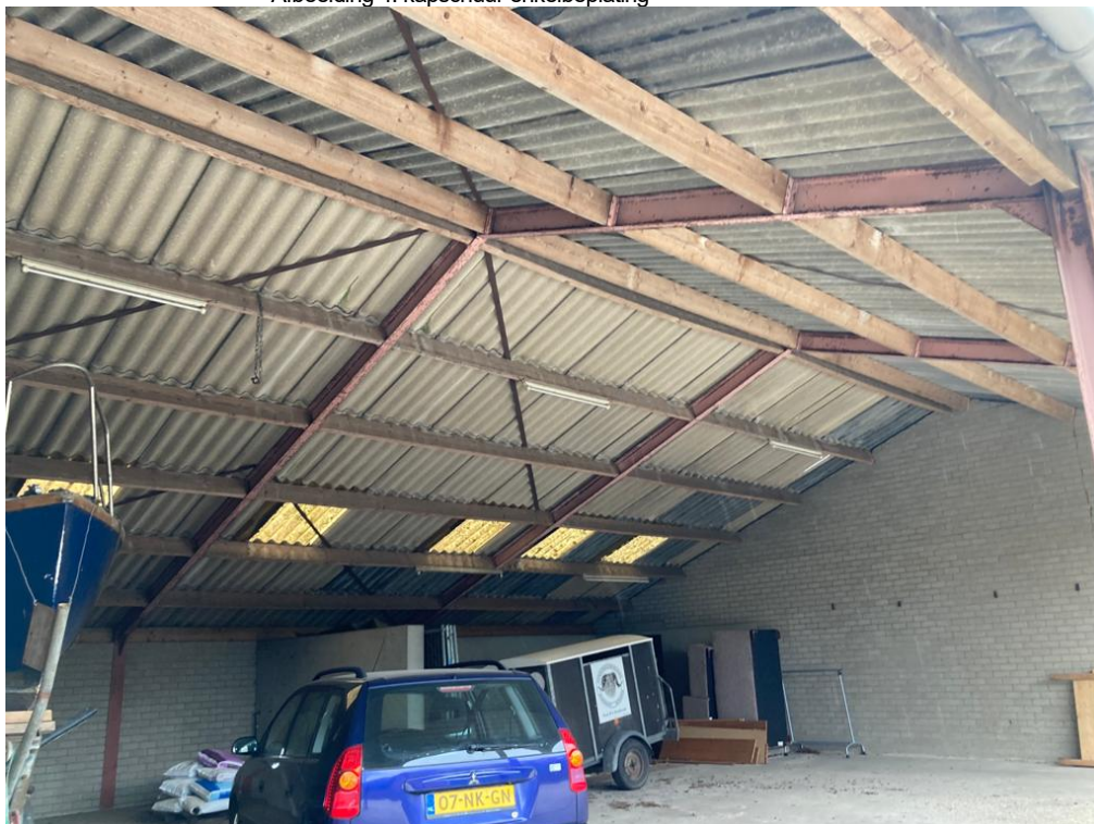
• Afbeelding 4: kapschuur enkelbeplating
