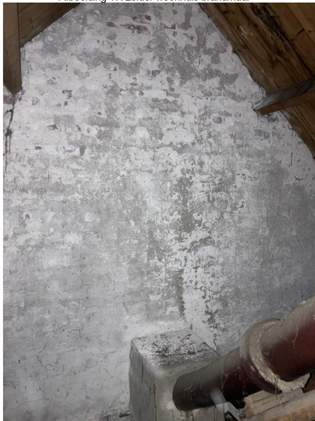
• Afbeelding 17: zolder woonhuis brandmuur
