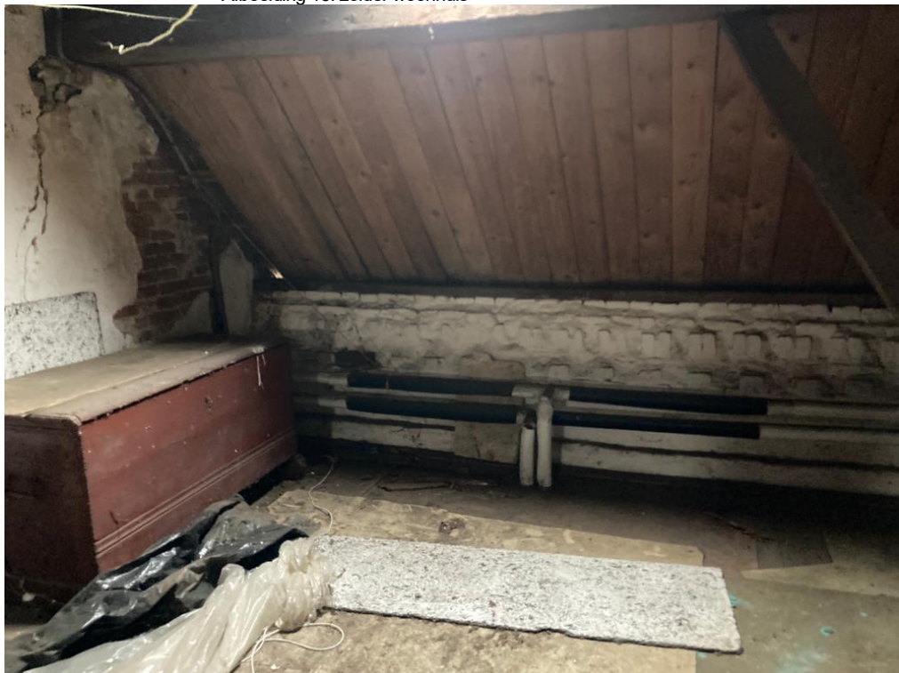
• Afbeelding 13: zolder woonhuis
