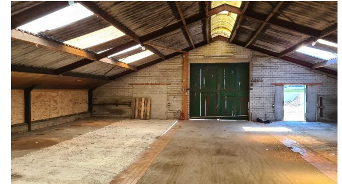
Figuur 12: Binnen aanzicht van de zuidelijke opstal, waarbij golfplaten en openingen zichtbaar zijn
