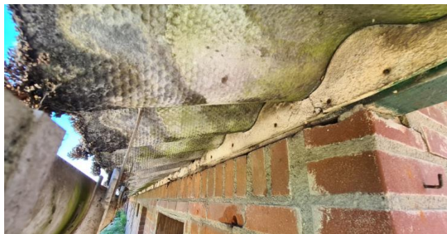
Figuur 8: Detailopname van dakrand opstallen, waarbij de afsluiting tussen golfplaten en gevel zichtbaar zijn
