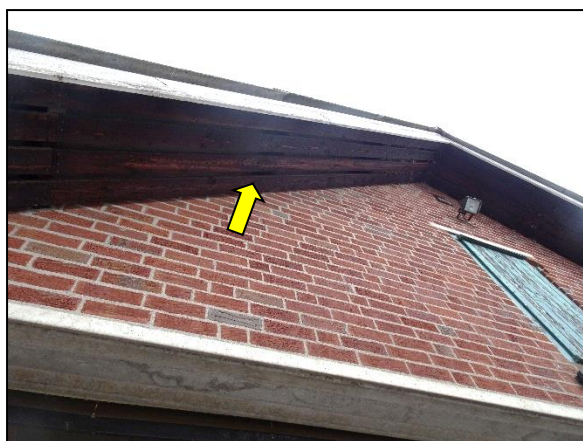
Figuur 19. Toegang voor vleermuizen tot enkele ruimtes tussen muren via open dak betimmering.
