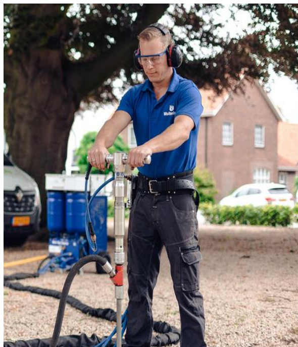
Figuur 16: verdichte grond kan na de bouwwerkzaamheden worden hersteld door middel van grond ploffen (grond injectie methode)
