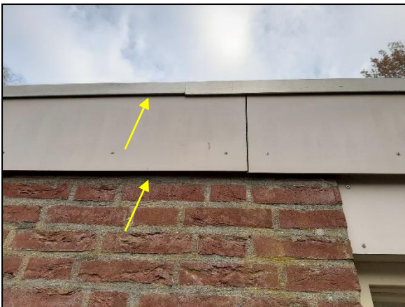
Figuur 30. Ruimte achter daktrim en betimmering geschikt voor vleermuizen.
