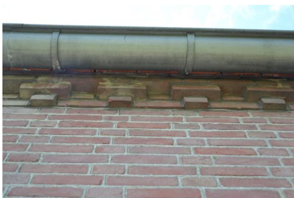
Bloklijst in voorgevel
