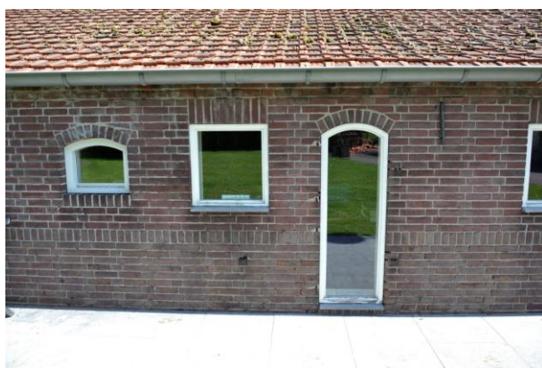
Verskillende typen venster in achtergevel, waaronder in de vm. varkensdeuropening
