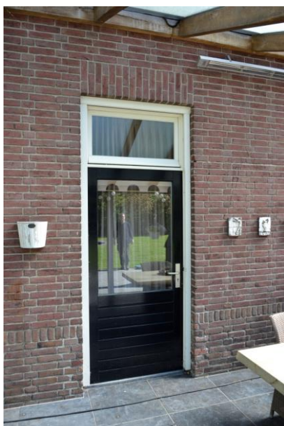
Vernieuwde deur in achtergevel.
