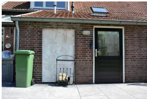
Voormalige staldeuropeningen in achtergevel
