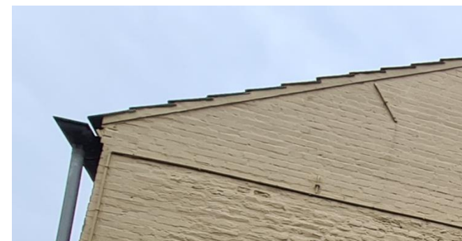
Figuur 16: Dak en dakrand van Breestraat 25
