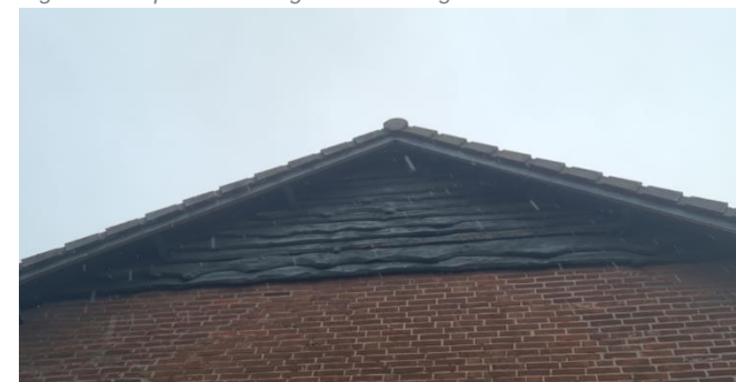
Figuur 20: Open stootvoegen in de oostgevel van Breestraat 25
