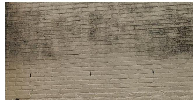
Figuur 20: Open stootvoegen in de oostgevel van Breestraat 25
