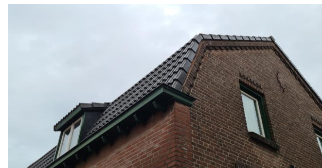
Figuur 19: Dakrand en dakkapel van Breestraat 12
