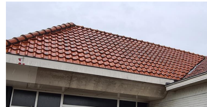
Figuur 11: Dak en dakrand van Breestraat 8
