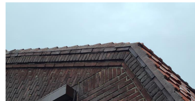
Figuur 12: Dak en dakrand van Breestraat 10
