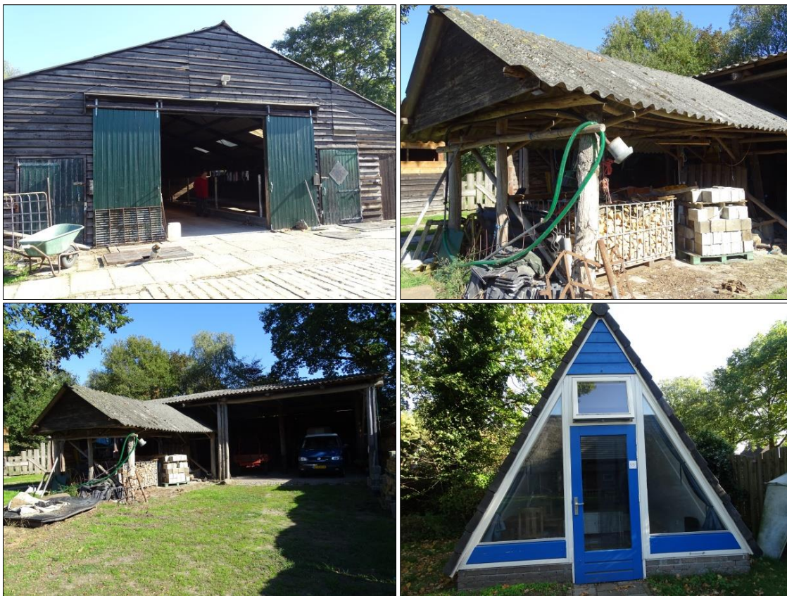
Foto's 7 t/m 10. Linksboven de westzijde van de pinkenstal. Rechtsboven de kleine overkapping (7). Linksonder de kleine overkapping (7) met de wagenschuur (6). Rechtsonder het gastenverblijf (8).
