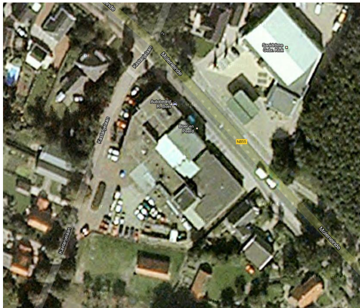
Afbeelding 1: Luchtfoto plangebied (Google Earth)
