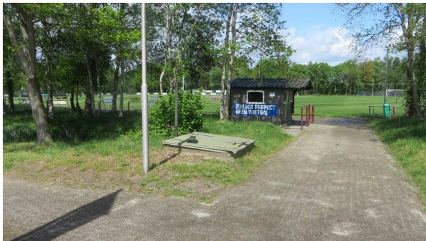
Foto 3: Pompkelder met op de achtergrond de blokhut (kassa) uit 1995.
