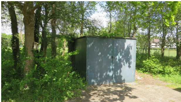
Foto 5: De Prefab garage.
