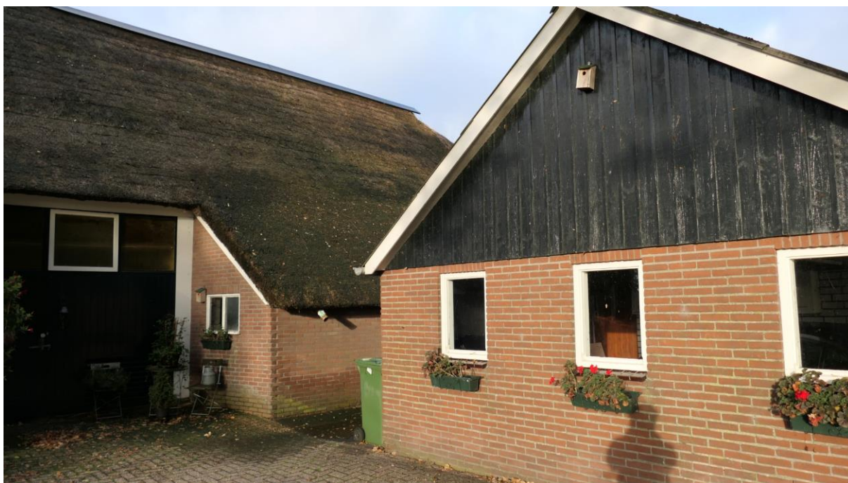
Figuur 1.4 Garage en deel van de woning (links).
