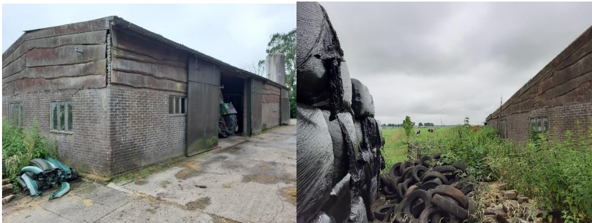
Figuur 2. Foto's bestaande situatie
