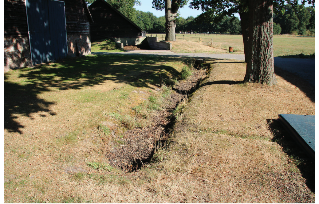
Greppel achterzijde nr 27/29.
