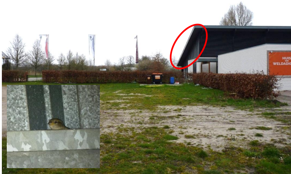
Foto 2 Locatie van de Huismusnesten in het hoofdgebouw (rode ovaal) en de beukenhagen langs het gebouw.
