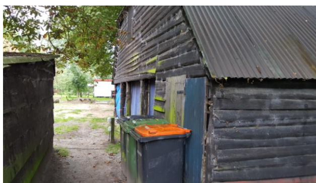
Twee van de drie houtenschuren met asbestdaken
