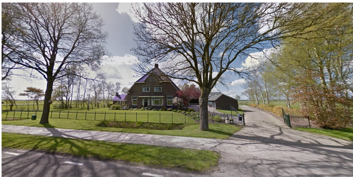
figuur 1.1: De locatie Westeinde 187 (bron: Google StreetView)
