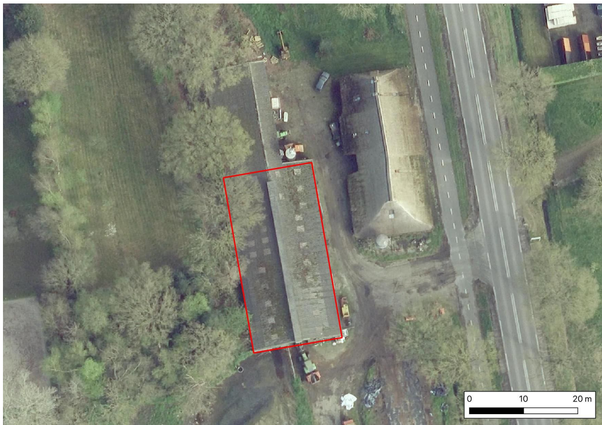
Figuur 2. Te slopen melkveestal (rood).
