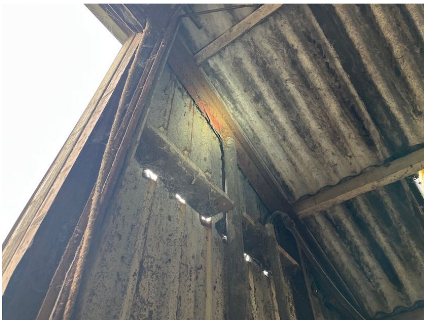
Figuur 10. Spant langs de dakrand van de kopgevel.
