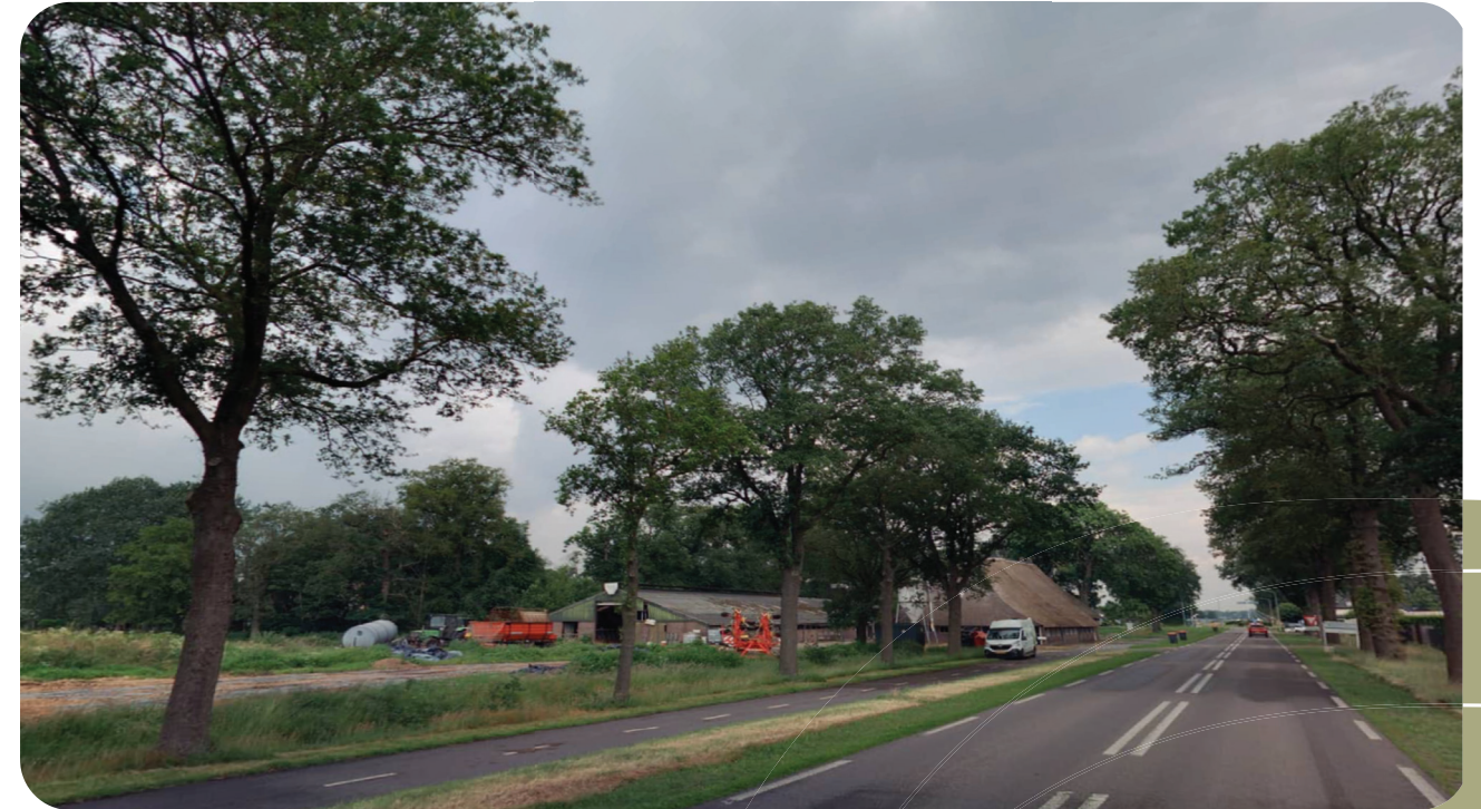
Straatbeeld vanaf de Van Helomaweg. Goed te zien is dat er in de huidige situatie sprake is van veel buitenopslag. Met de bouw van een nieuwe loods moet dit worden voorkomen.
