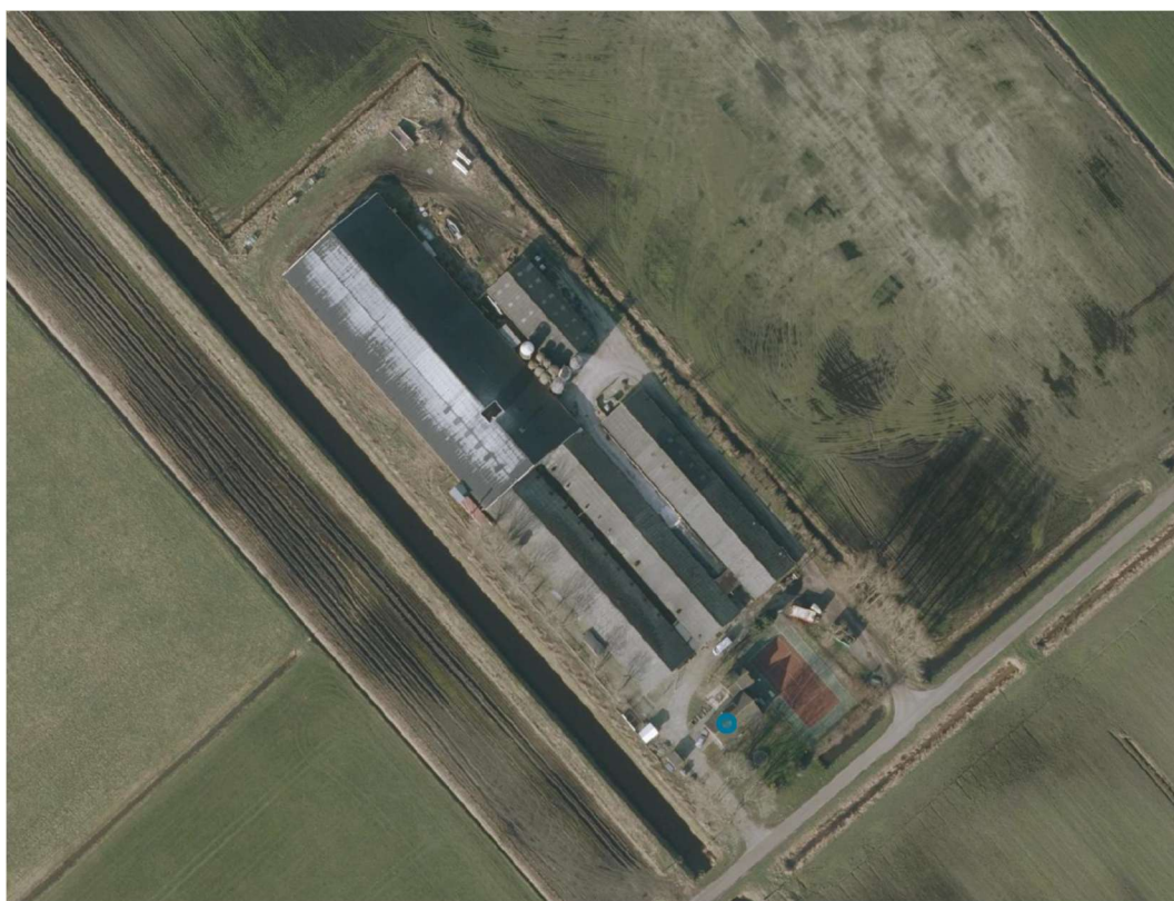
Afbeelding 1: luchtfoto bestaande situatie
