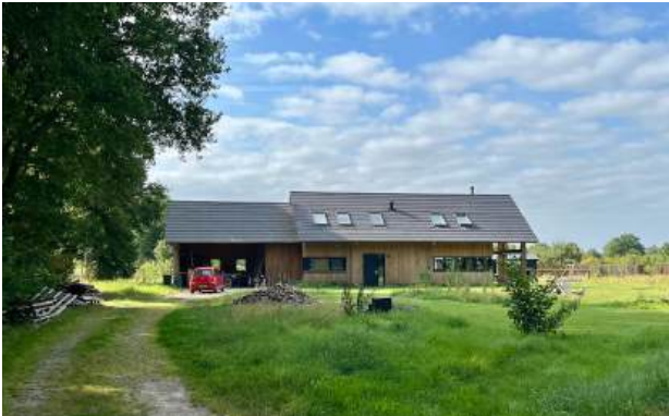
Geïntegreerde schuur aan 'erf-zijde' (in volume ondergeschikt)
