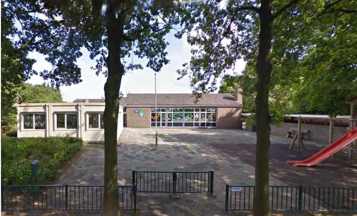
Schoolgebouw, 2009. Bron: Google Maps
