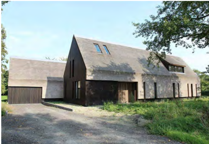
Moderne boerderijwoning met rieten kap Bron: Grasodenridder Architecten
