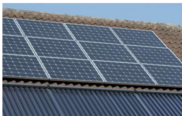
Zonnecollectoren / -panelen
