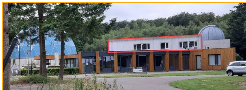
Figuur 2. Rood omlijnd is het metalen gedeelte dat afgetimmerd wordt met hout.
